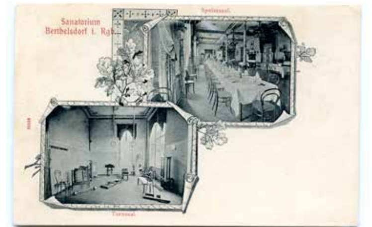
Wnętrze sanatorium – w tym siłownia
